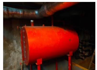
ระบบ Engine ใช้น้ำมันเดินปั๊มฉีดน้ำดับเพลิงกรณีไฟฟ้าดับ
