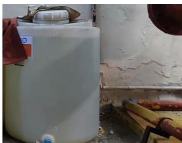
ระบบเติมคลอรีนถังพักน้ำ Under Ground Tank
