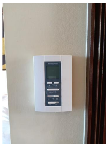
ชุดควบคุมอุณหภูมิห้องปรับอากาศ
